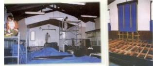
礼拝堂外壁の塗装（〇6年）
